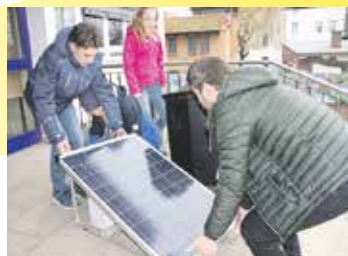
Hier wird das Solarmodul aufgestellt ...
